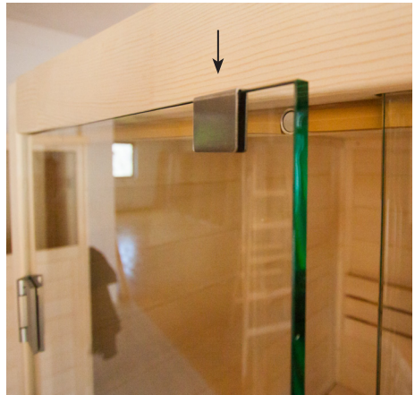
Kunststoff Beilagscheibe bei Niro-Griff beilegen
