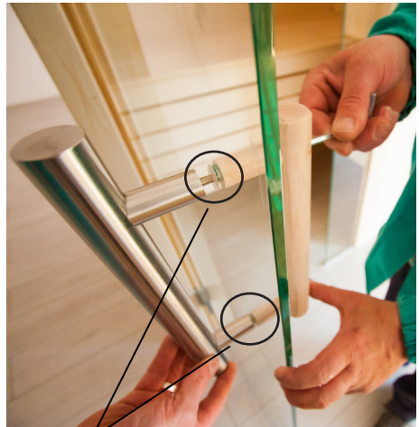
Applicare rondelle di plastica nelle maniglie Nirosta
