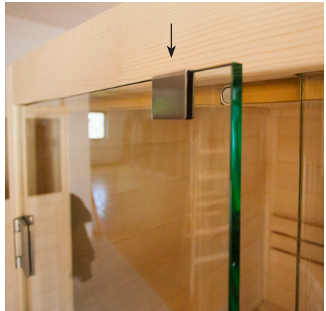
Applicare rondelle di plastica nelle maniglie Nirosta
