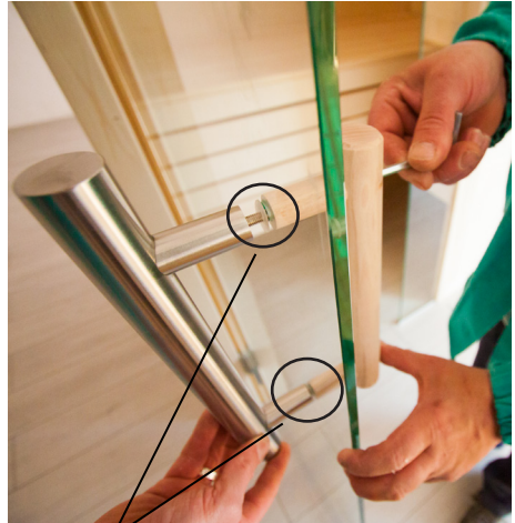
Kunststoff Beilagscheibe bei Niro-Griff beilegen
