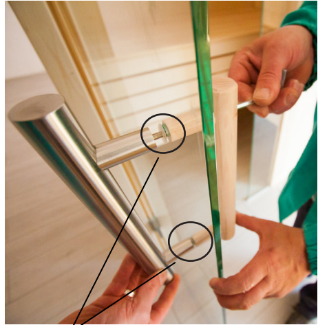
Applicare rondelle di plastica nelle maniglie Nirosta
