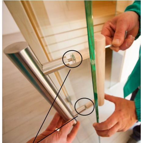
Kunststoff-Beilagscheiben bei Niro-Griff beilegen
