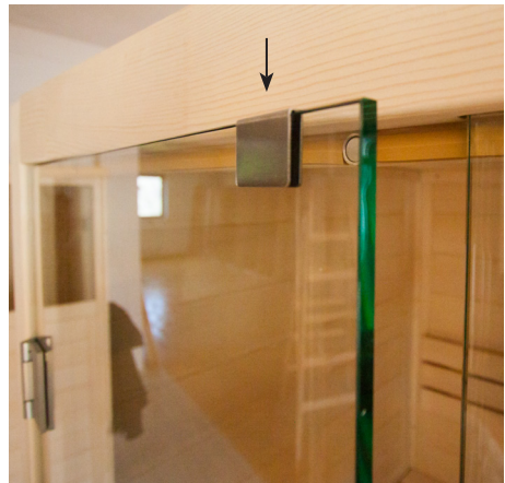
Kunststoff-Beilagscheiben bei Niro-Griff beilegen
